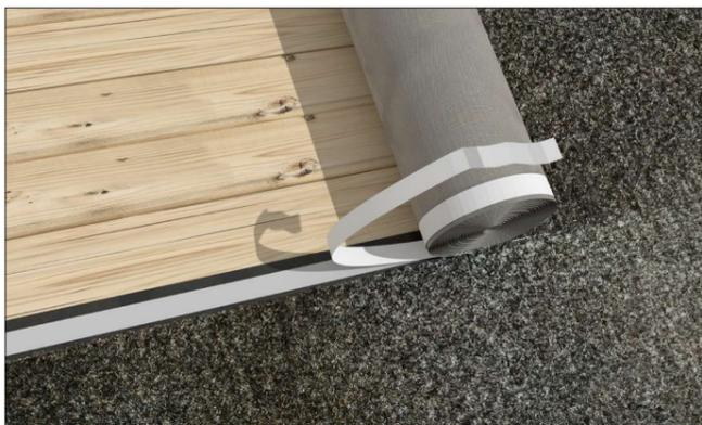
Bei nutzbaren Dachgeschossen ist es empfehlenswert, die Bahnen nacheinander zu verkleben (entweder mit dem doppelseitigen Klebeband mdm ViBest Duo oder dem Produkt mit integrierten Klebestreifen – Bezeichnung T / TT). Verlege-/Verklebetemperatur > +8 Grad Celsius. Die maximal zulässige Einwirkungszeit der UV-Strahlung auf die Dachbahn ist in der Tabelle mit den technischen Parametern des Produkts genau definiert.
